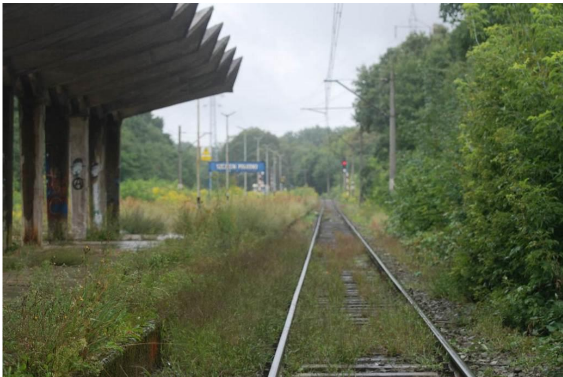
Fot. Widok na torowisko w rejonie stacji kolejowej Pogodno
