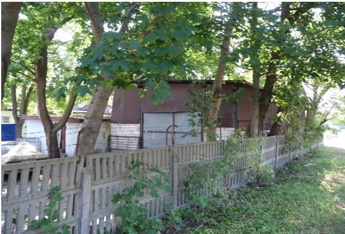
Fot. Budynki magazynowe murowane przy ul. Twardowskiego na odcinku pomiędzy ul. Witkiewicza i 26 Kwietnia.
