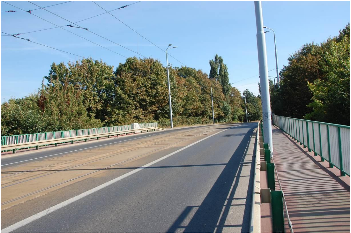
Fot. Widok na wiadukt w ciągu ul. Mickiewicza.
