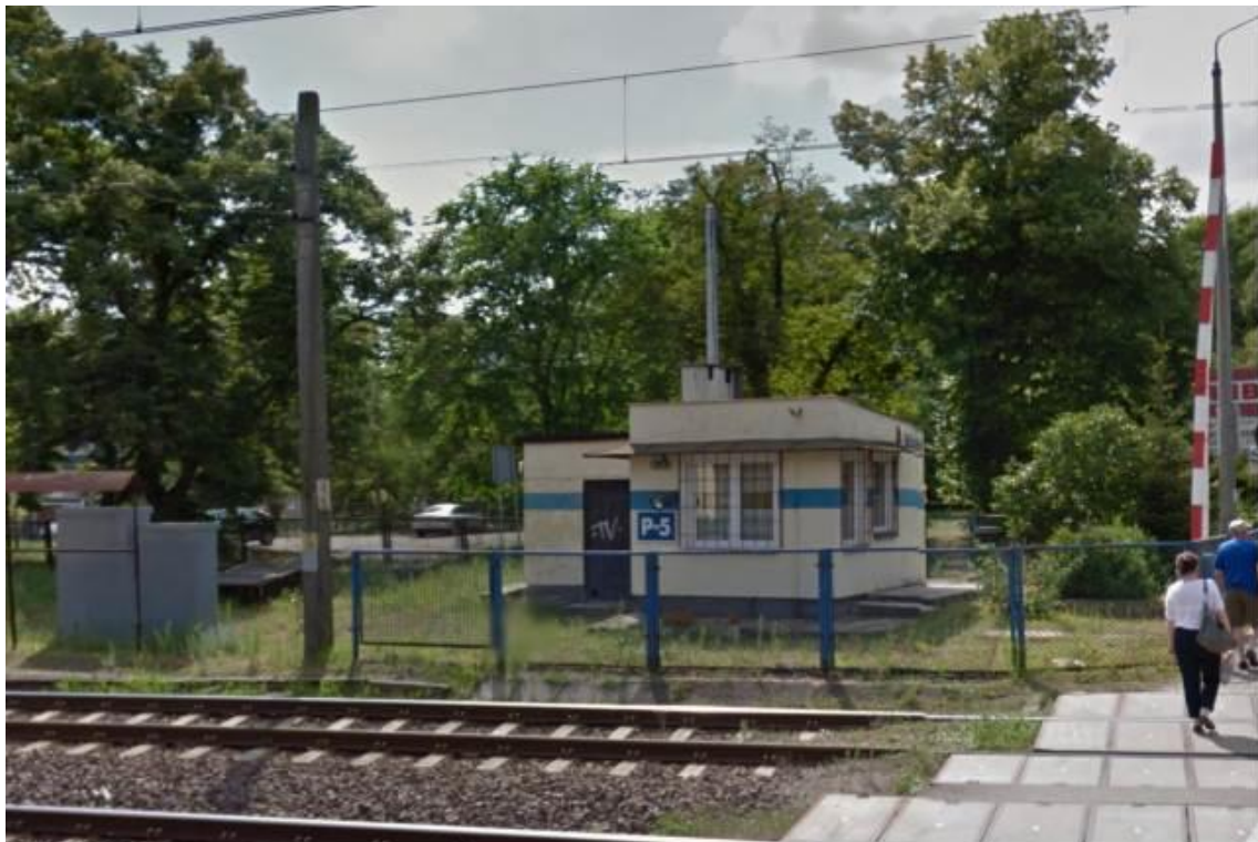
Fot. Stróżówka przewidziana do rozbiórki (obiekt przy przejeździe kolejowym w ciągu ulic Jagiellońskiej i Witkiewicza)
