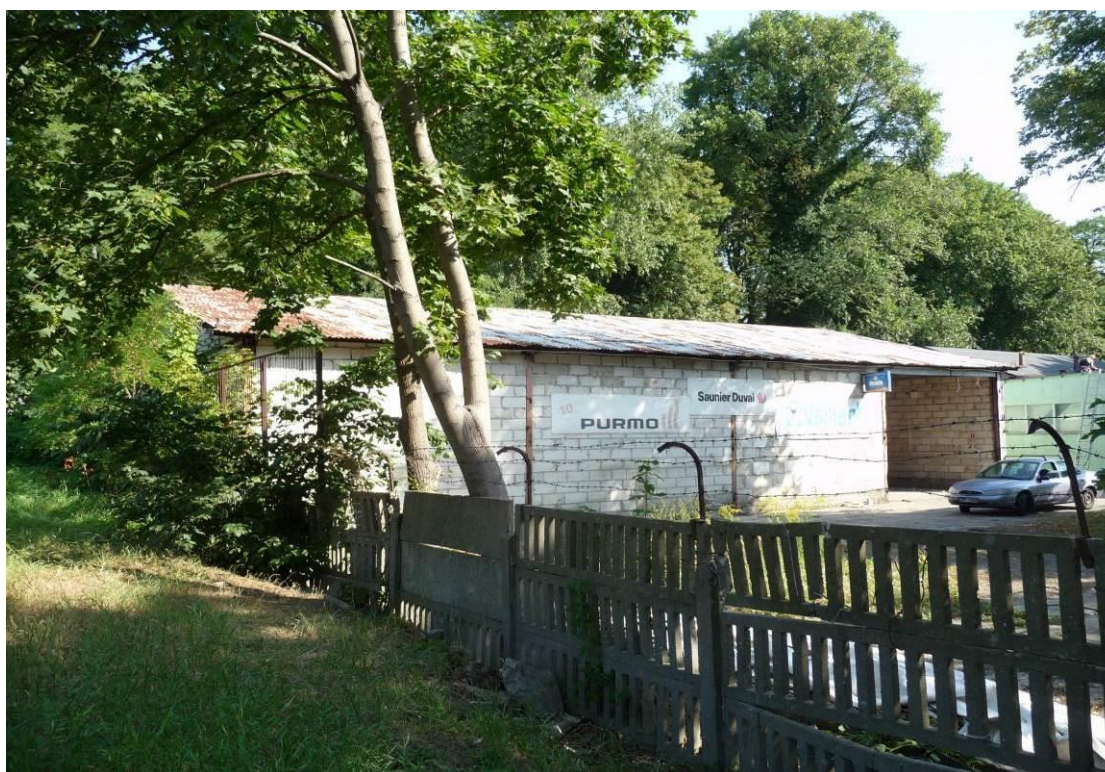
Fot. Budynek magazynowy murowany kryty blachą falistą przy ul. Twardowskiego na odcinku pomiędzy ul. Witkiewicza i 26 Kwietnia.
