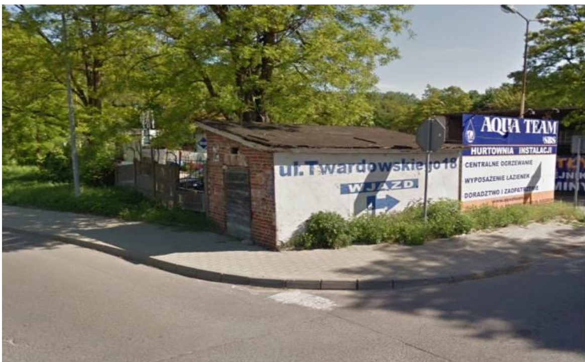
Fot. Budynek magazynowy kryty papą przy ul. Twardowskiego na odcinku pomiędzy ul. Witkiewicza i 26 Kwietnia.
