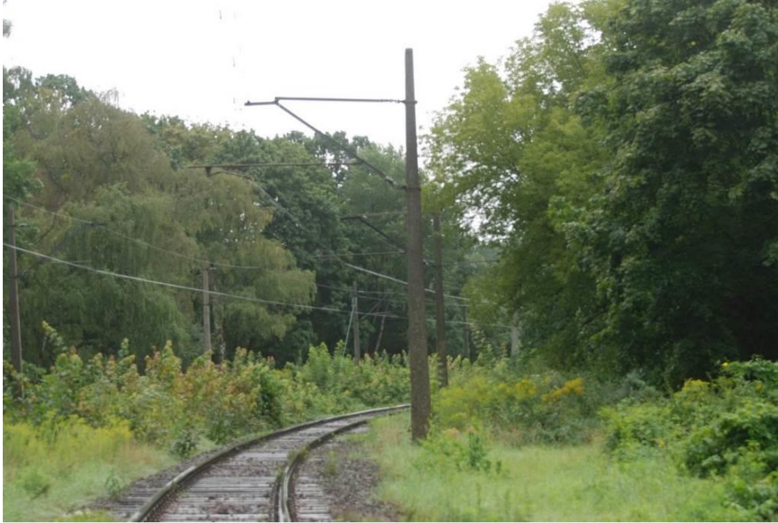
Fot. Widok na torowisko pomiędzy wiaduktem kolejowym nad ulicą Mickiewicza i ulicą Zaleskiego
