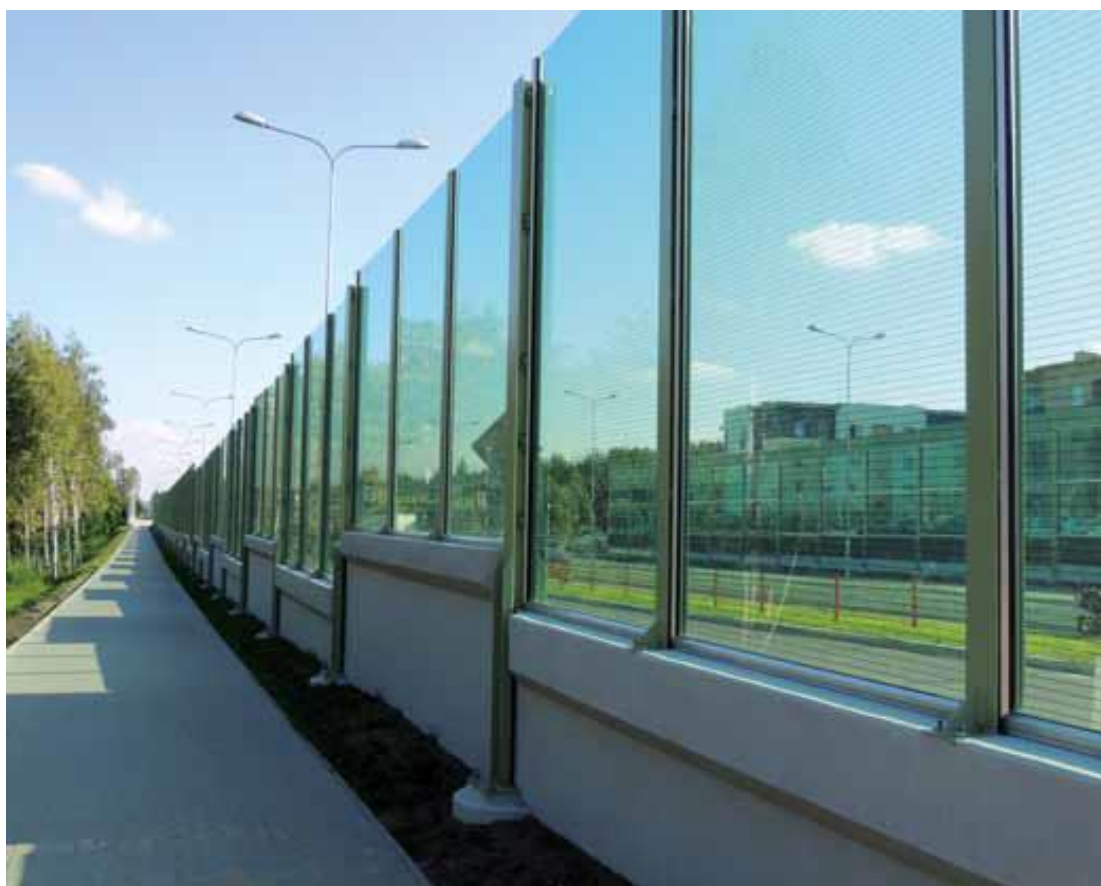
Ryc. Czarne wąskie paski o szer. ok. 2 mm, oddalone od siebie o ok 30 mm minimalizują efekt „lustro”
