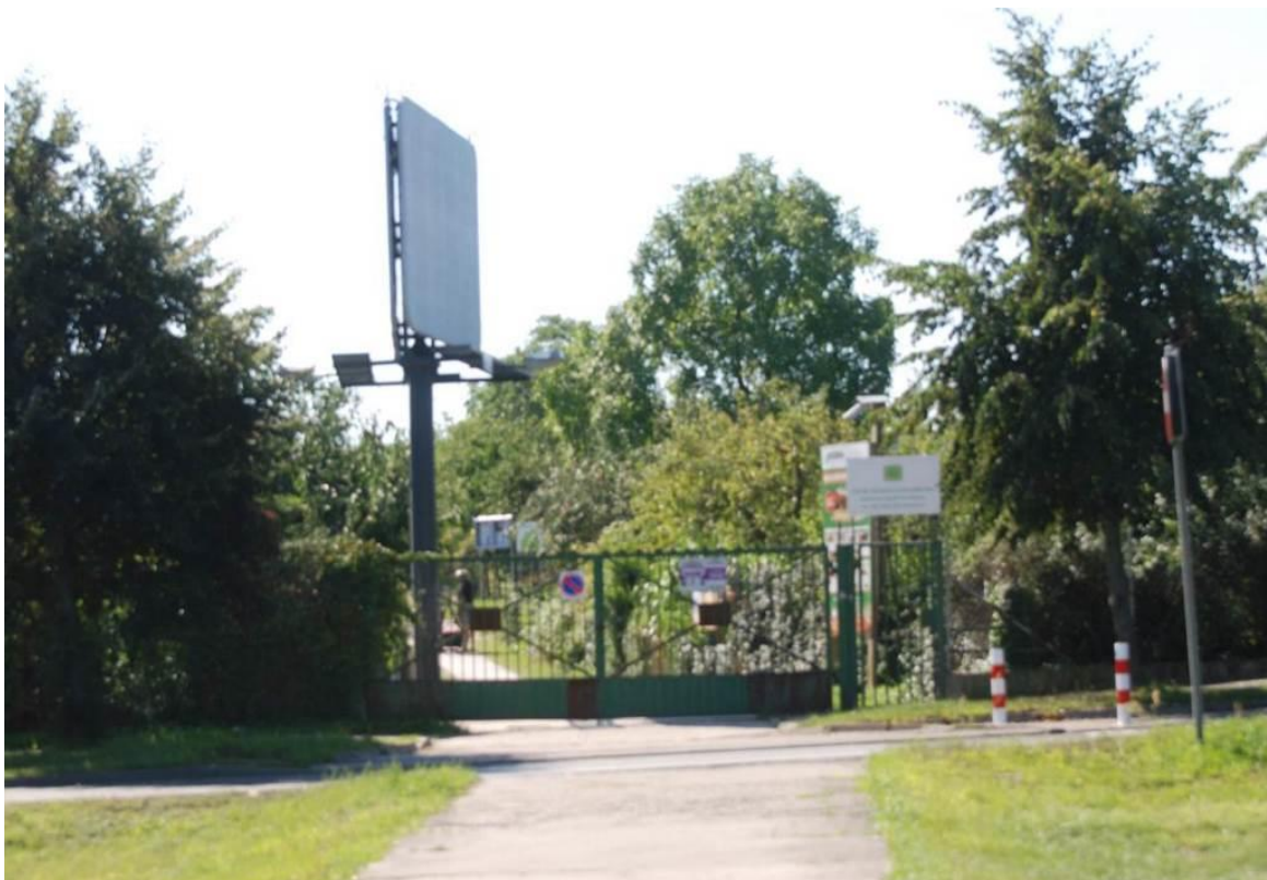
Fot. Widok na wjazd do rodzinnego ogrodu działkowego po stronie południowej ulicy 26 Kwietnia
